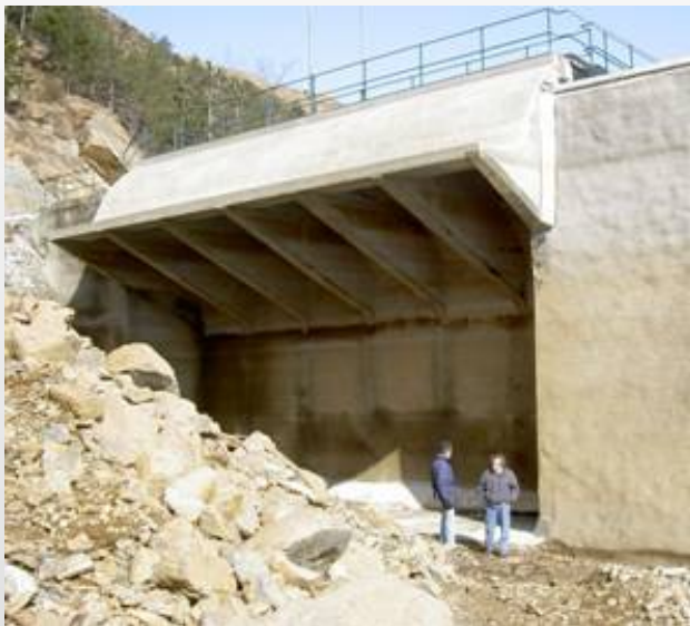
diga Badana: scarico superficiale a sifoni (funzionamento automatico impulsivo)
