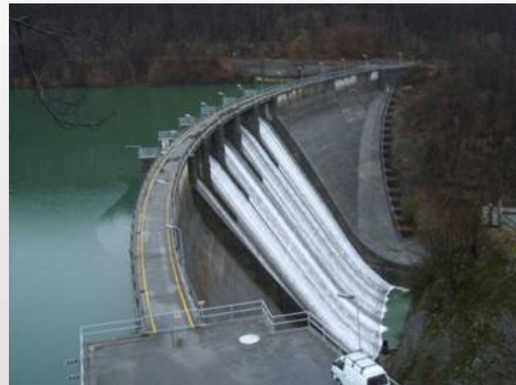
diga Busalatta: scarico superficiale a soglia tracimante
